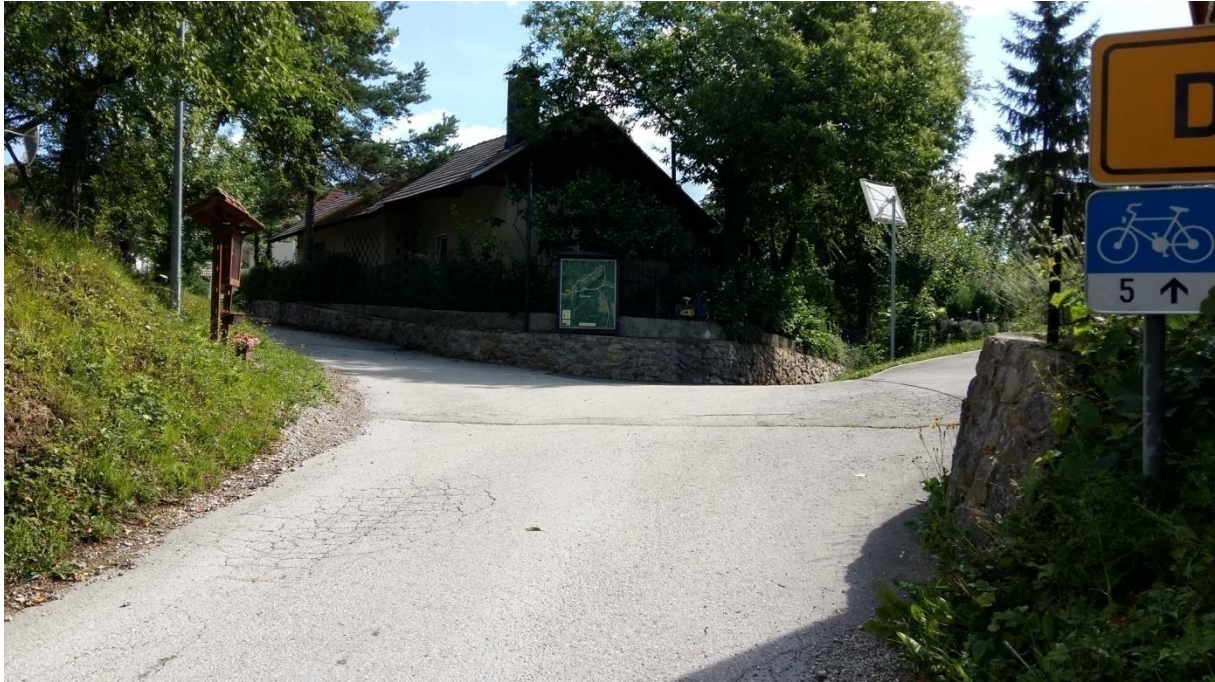
Slika 8: Postajališče v Dobovljah ni pregledno, cesta je brez pločnika. Šolar mora hoditi po levi strani roba cestišča.
